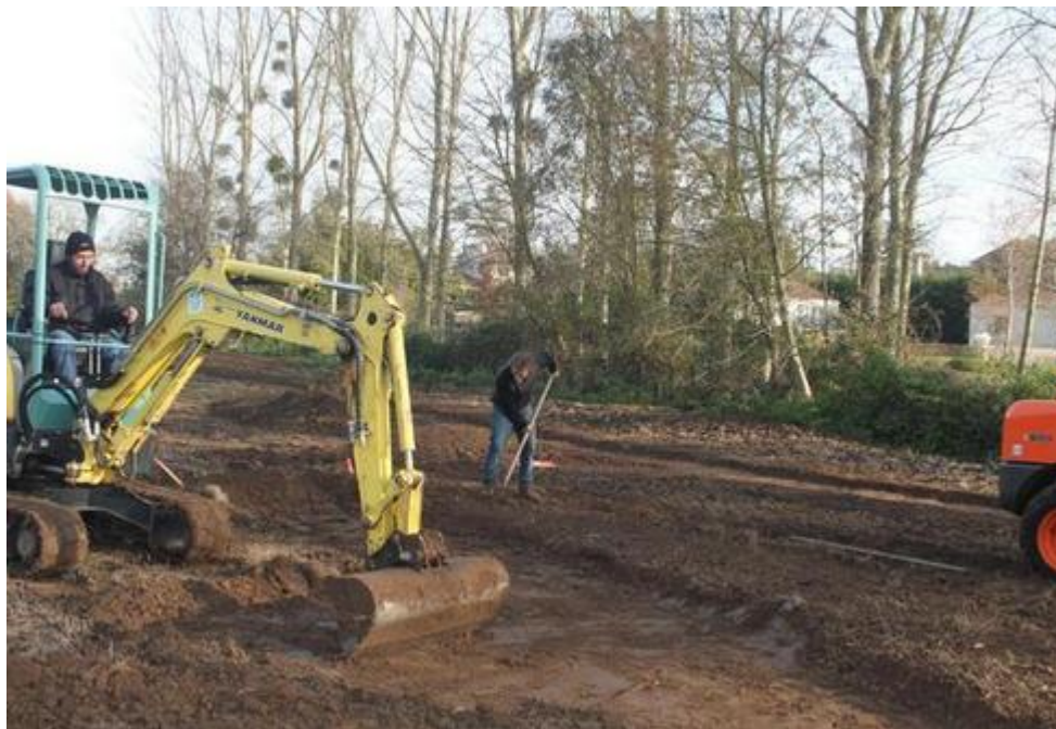
M. Pineau et sa société Uni'vert, ont commencé les travaux de terrassement
