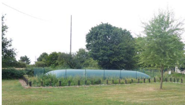
Réserve incendie : plantation N + 2 (juillet 2015)
